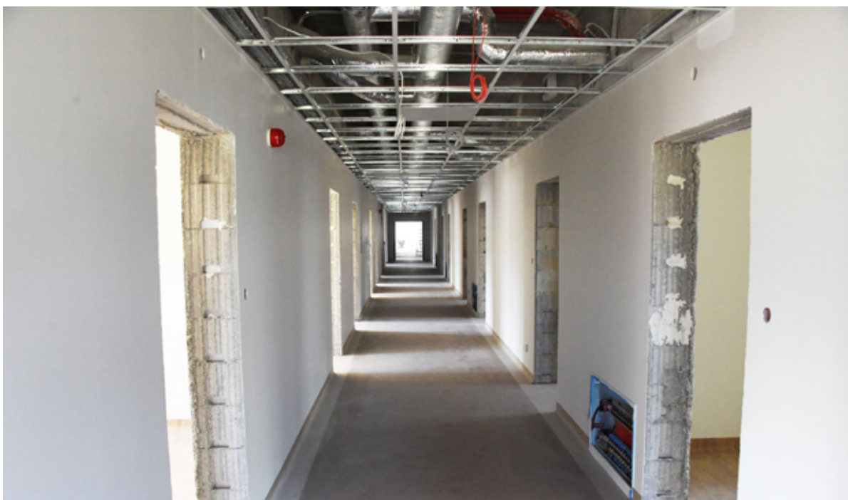
Ośrodek w budowie – ciągi komunikacyjne będą przestronne. (Zdjęcie – strona DPS)
