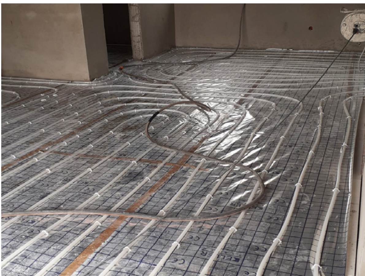
Podłogi będą ciepłe. (Zdjęcie – strona DPS)
