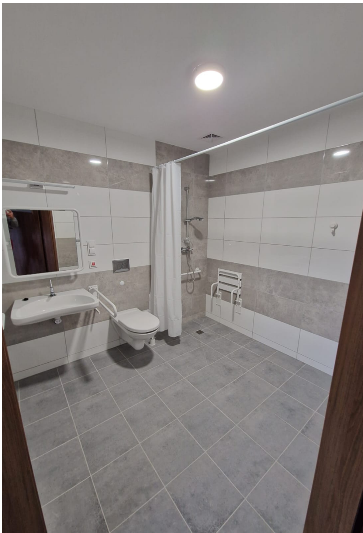
Jedno z pomieszczeń łazienkowych. (zdjęcie DPS)
