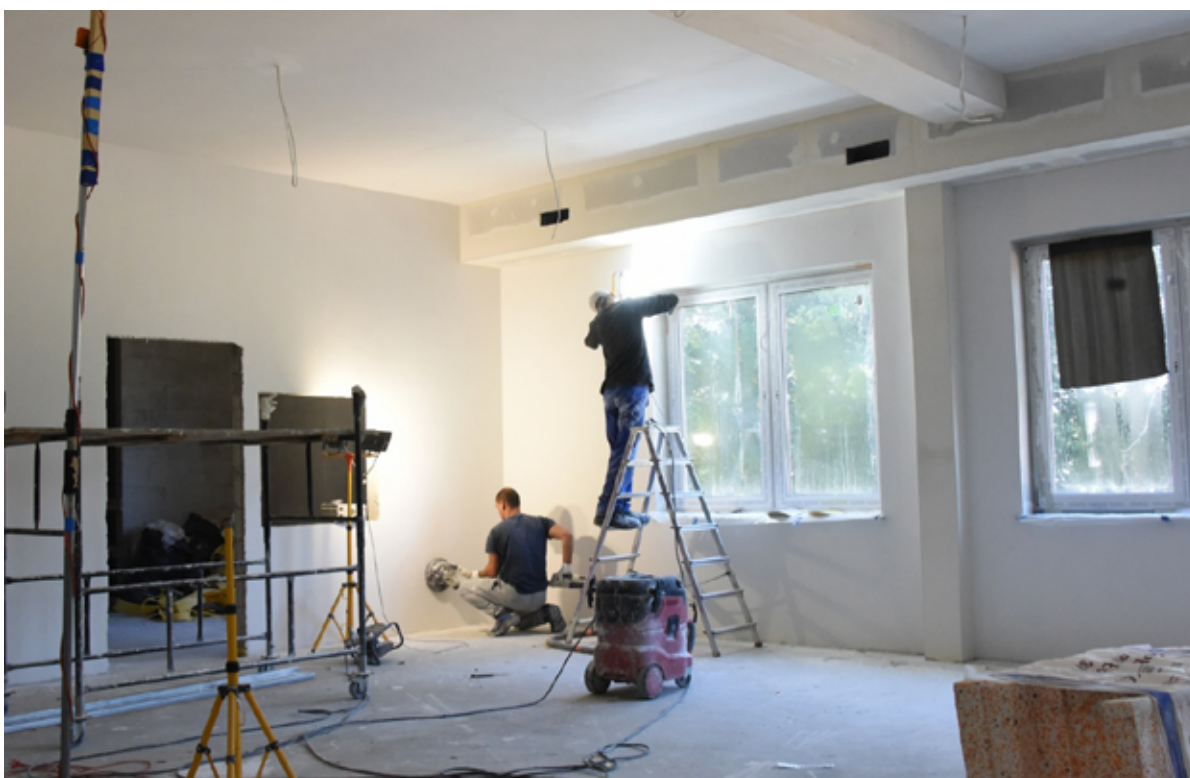
Prace wykończeniowe w ośrodku. (Zdjęcie – strona DPS)
