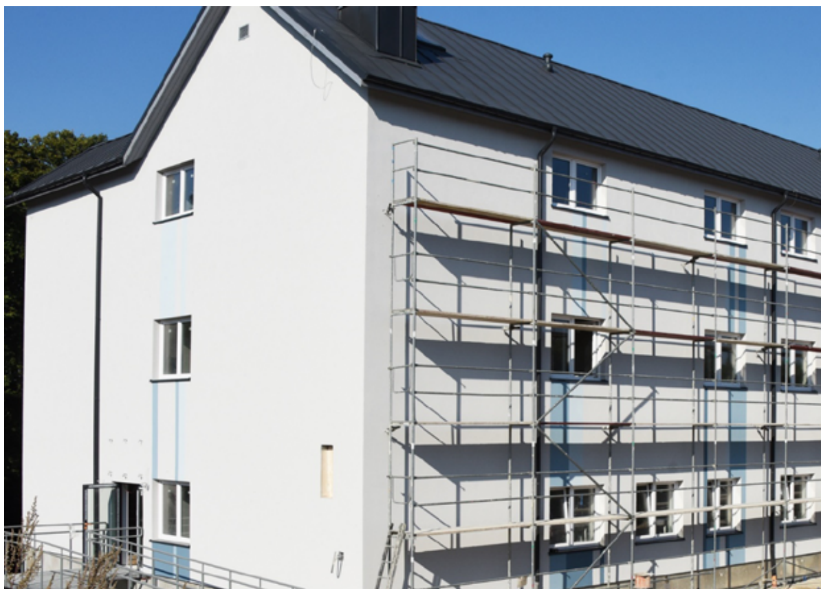
Ośrodek w budowie, zdjęcie – strona DPS)
