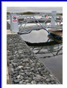
Umocnienie brzegów Fot. M. Gałczyńska
